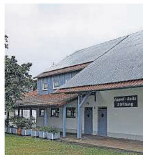
Die Appel-Seitz-Stiftung ist in einem ehemaligen Bauernhof untergebracht.
