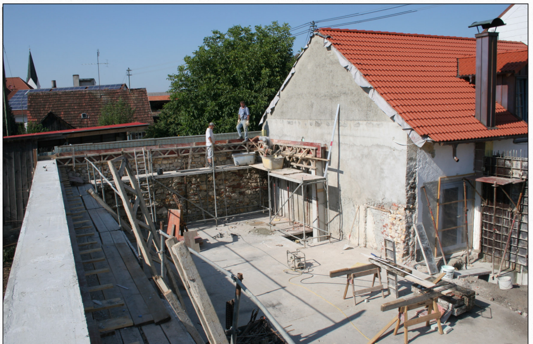
Sichtbarer Baufortschritt beim Kulturzentrum: Unlängst wurde der letzte Auftrag für den Rohbau vergeben. Foto: zbs
