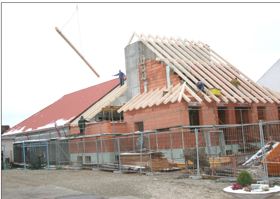
In den vergangenen Tagen wurden die Dachsparren eingezogen.
